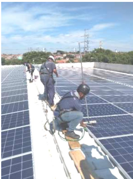
Figura 2 – Utilização de passarelas móveis de tábuas de madeira
